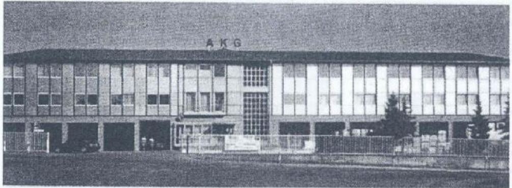
Die Autokühler GmbH & Co. KG in Hofgeismar
